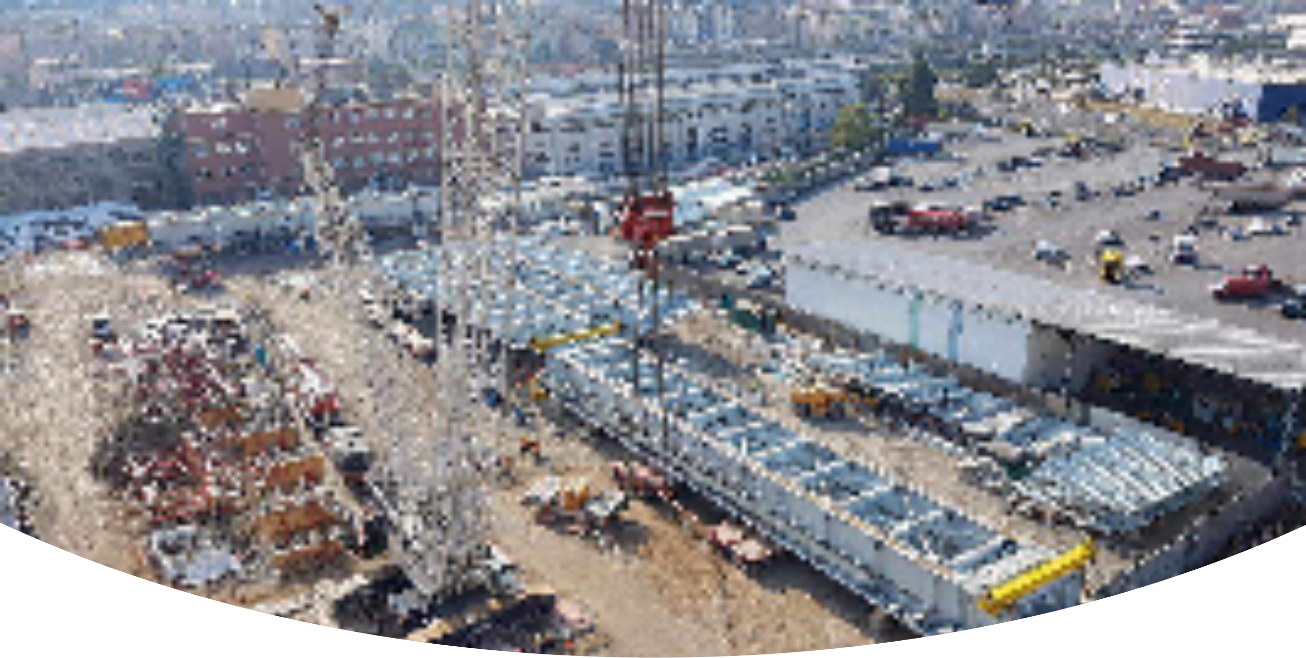
ASSEMBLAGGIO A TERRA DEGLI IMPALCATI METALLICI
